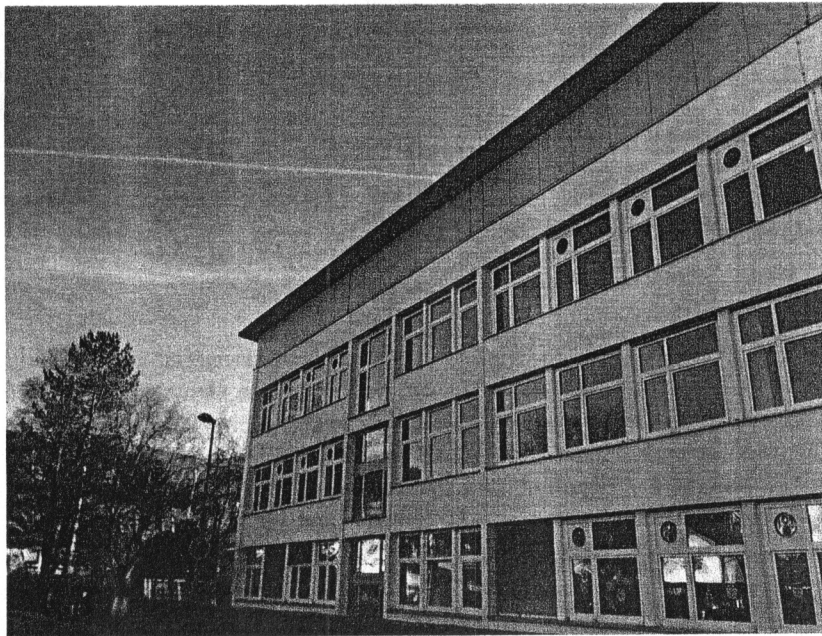
Bild 5.1 Die Ostfassade des Schulgebäudes in Gutach/Breisgau mit Öko-Lüftern in den Oberlichtern der Klassenzimmer
